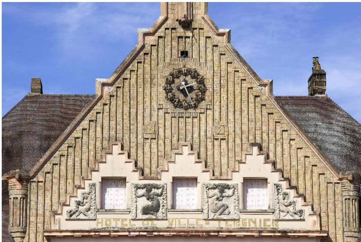
Détail du fronton de la façade principale.
