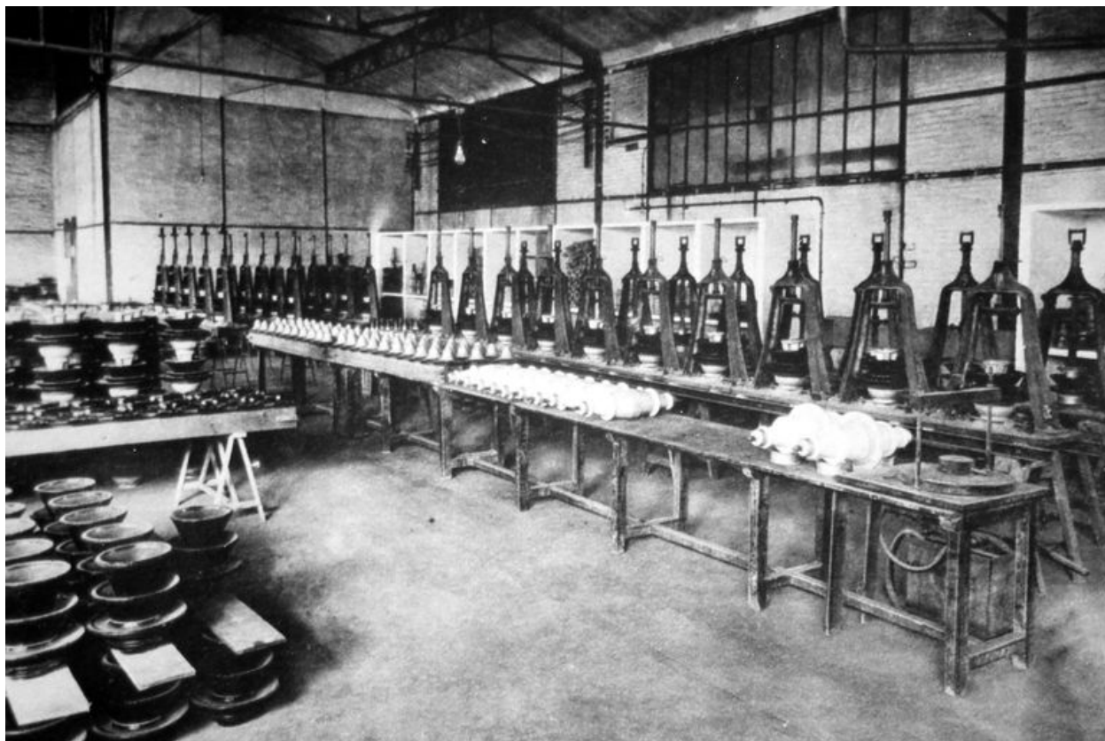
Vue de l'atelier de montage des isolateurs vers 1950.
