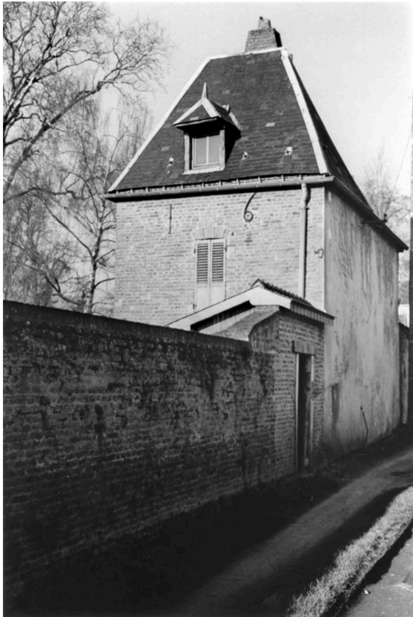
Vue générale du pavillon depuis l'impasse.
