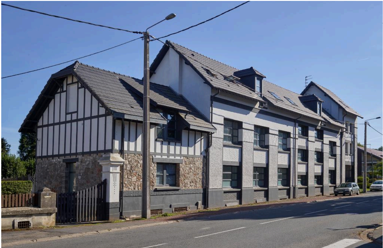
Vue de l'extrémité de la scierie vers la maison de maitre depuis la rue de Douai. Vue orientée Sud-Ouest - Nord-Est.
