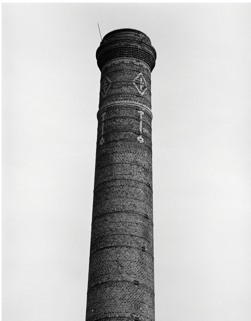
Atelier de fabrication, détail de la cheminée.
