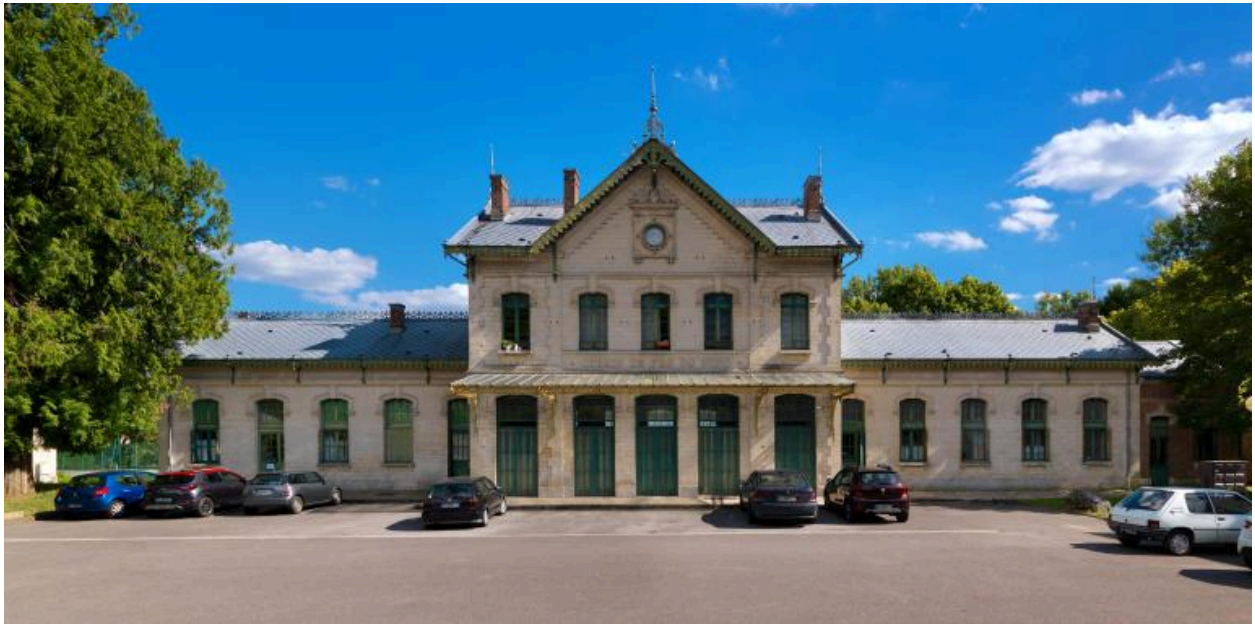
Vue générale de l'élévation nord et du parvis.
