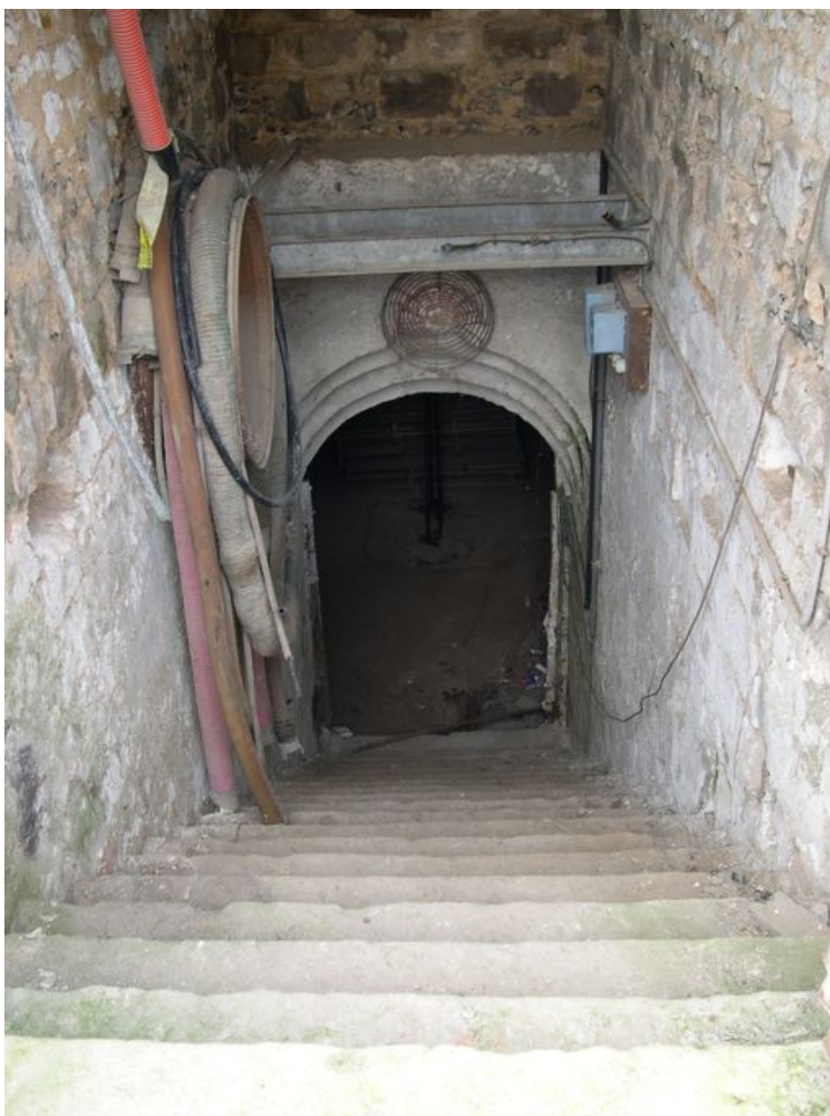
Détail sur l'accès aux caves.
