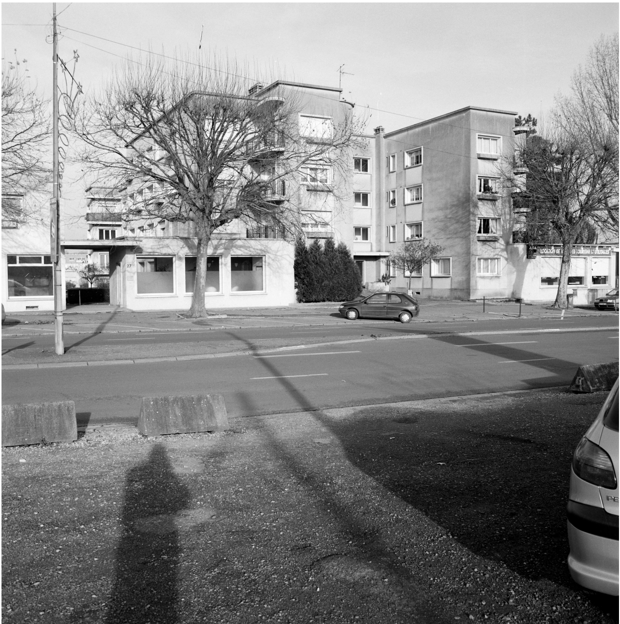
Vue générale du deuxième immeuble en forme de H.
