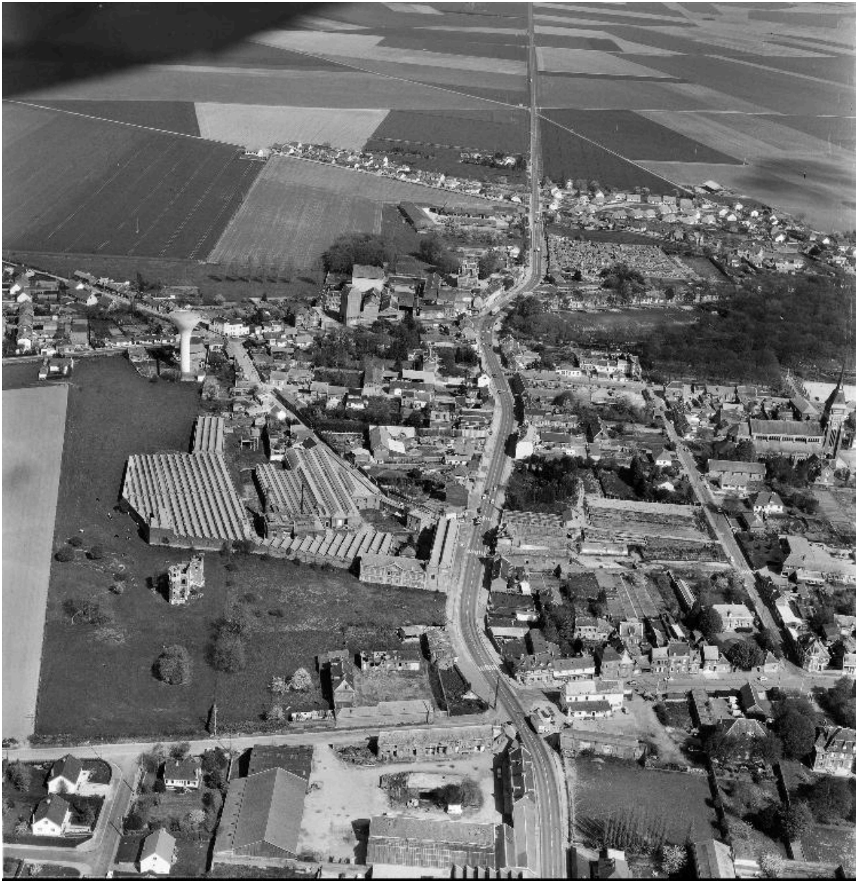
Vue aérienne montrant l'état de la propriété en 1988.
