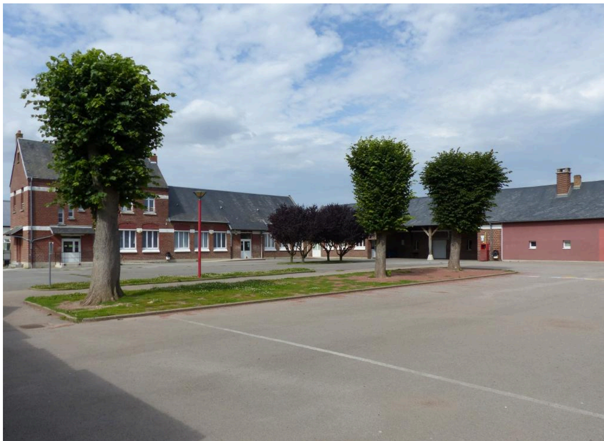
La cour de récréation. Vue depuis le sud-ouest.
