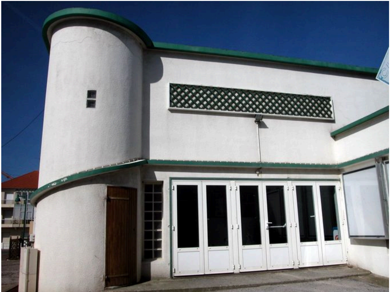
Détail de l'entrée.
