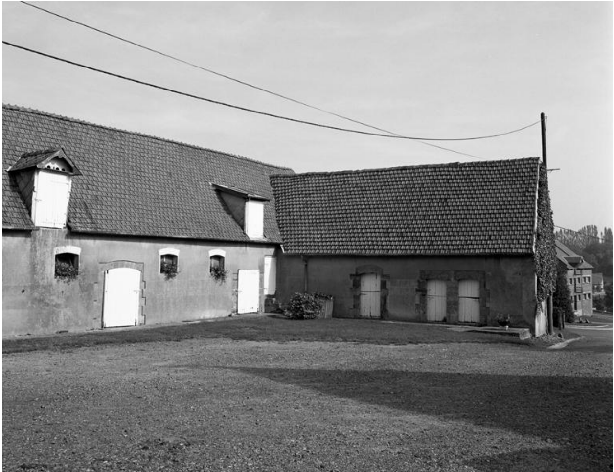
Vue de la cour et des façades des étables.
