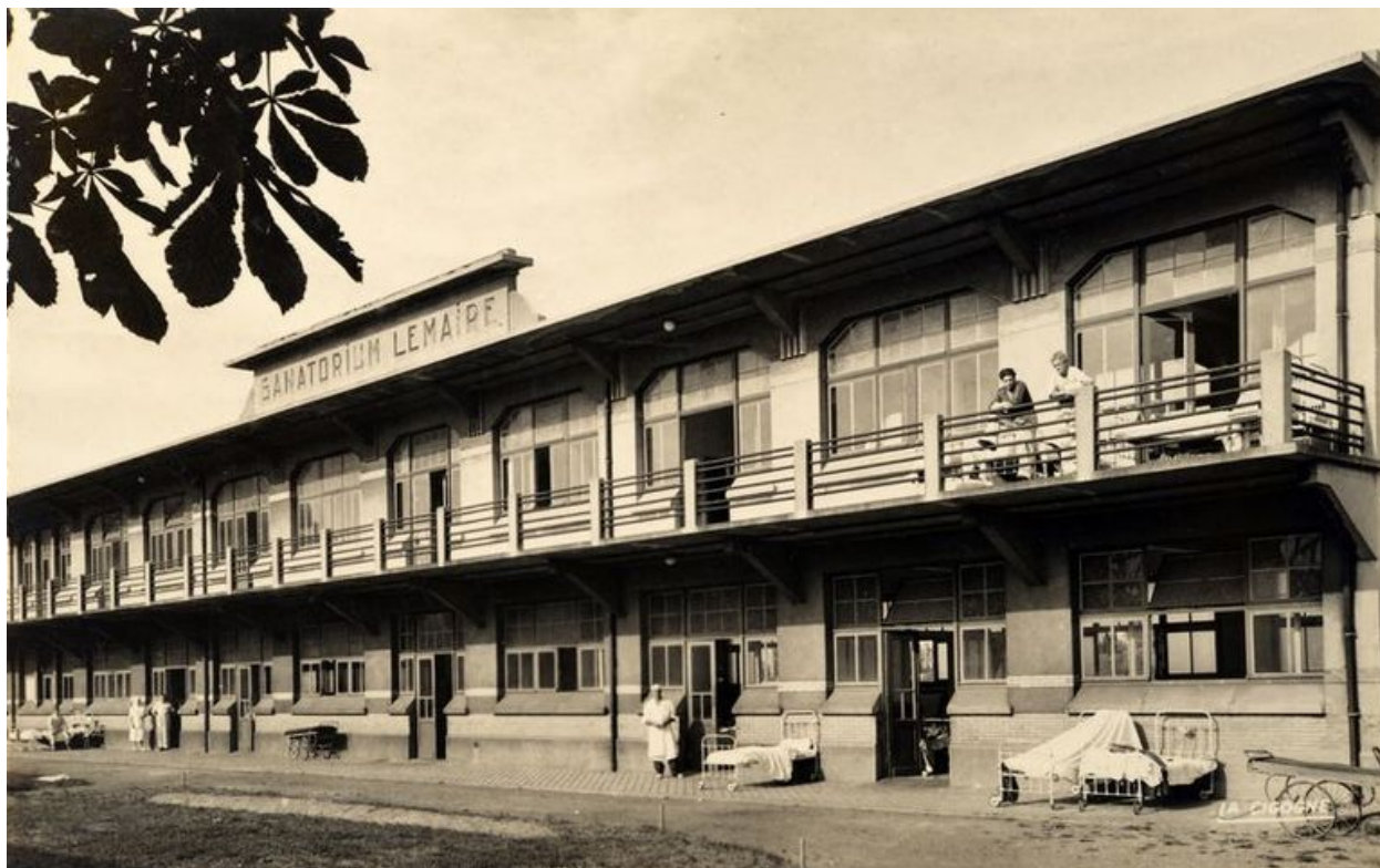
Un des deux bâtiments d'hospitalisation ajoutés à l'édifice primitif dans les années 1930, élévation antérieure, vue de trois-quarts droit. Carte postale, vers 1930 (coll. part.)
