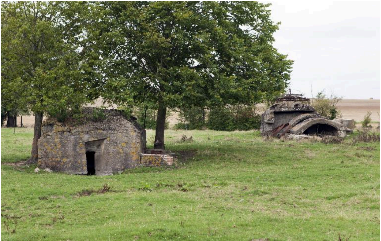
Vue générale vers le nord. (dans le fond à droite la casemate IA59004833)
