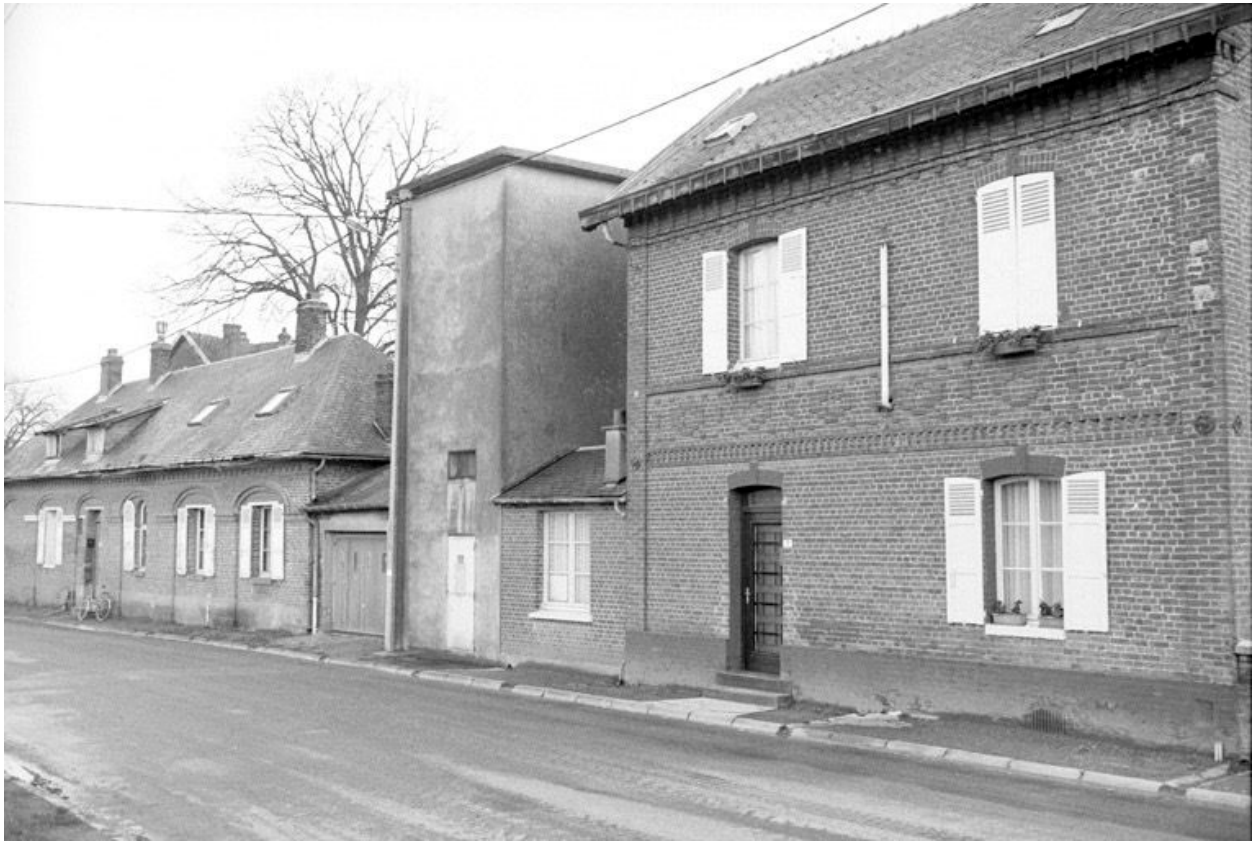
Conciergerie, transformateur, logement d'ouvriers, flanc nord.
