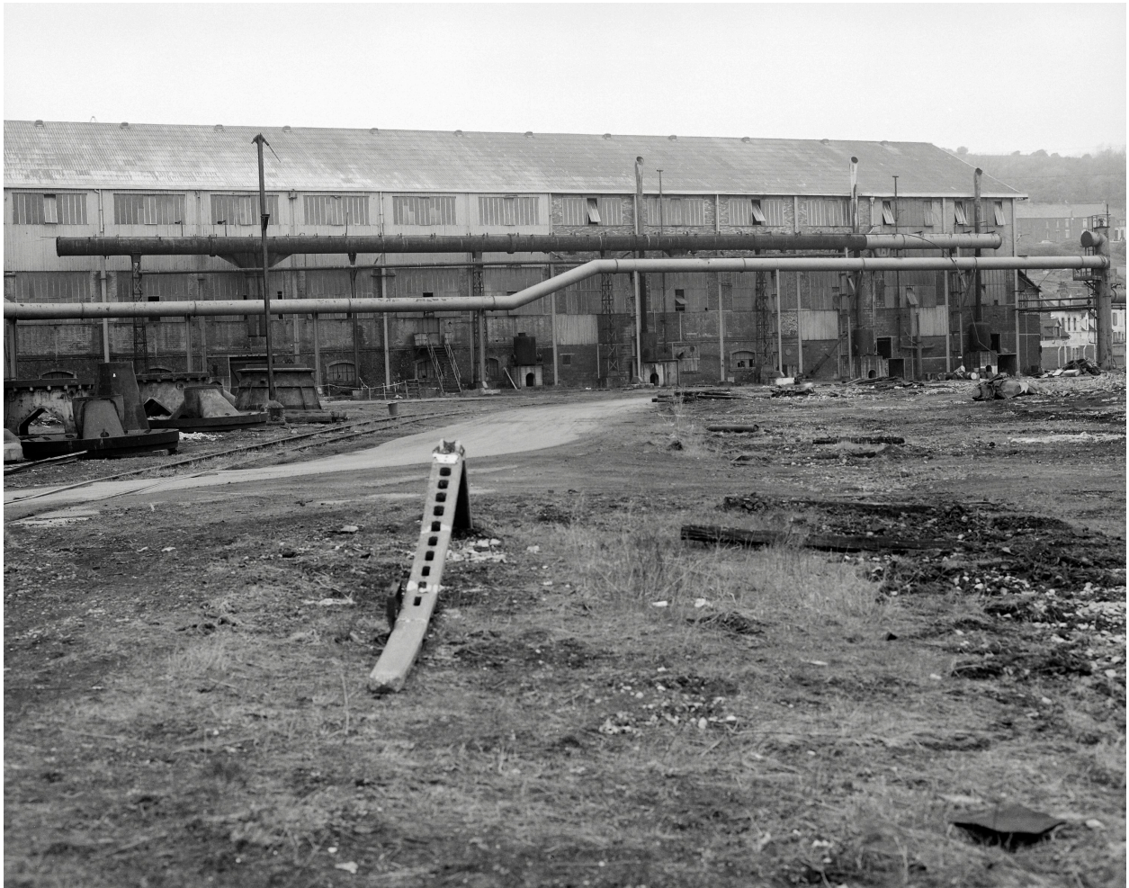
Centrale à gaz : façade sur cour.
