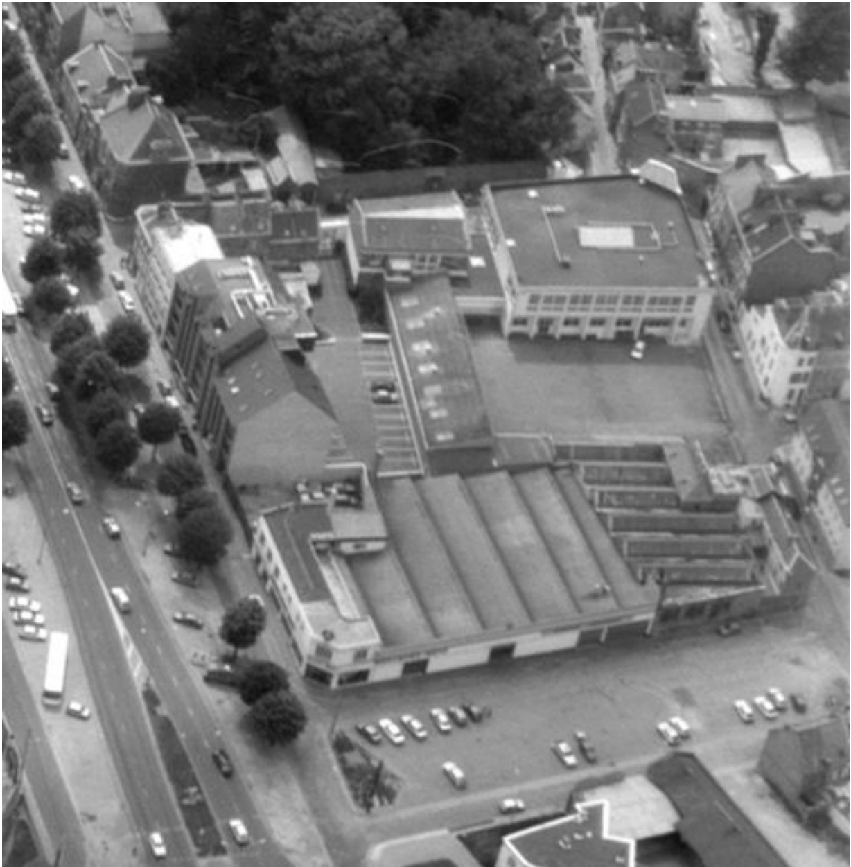
Vue aérienne, depuis le nord.
