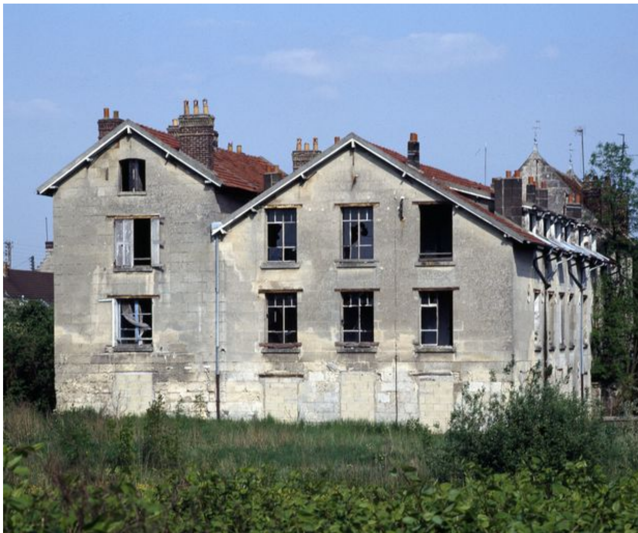
Vue générale, pignon ouest.
