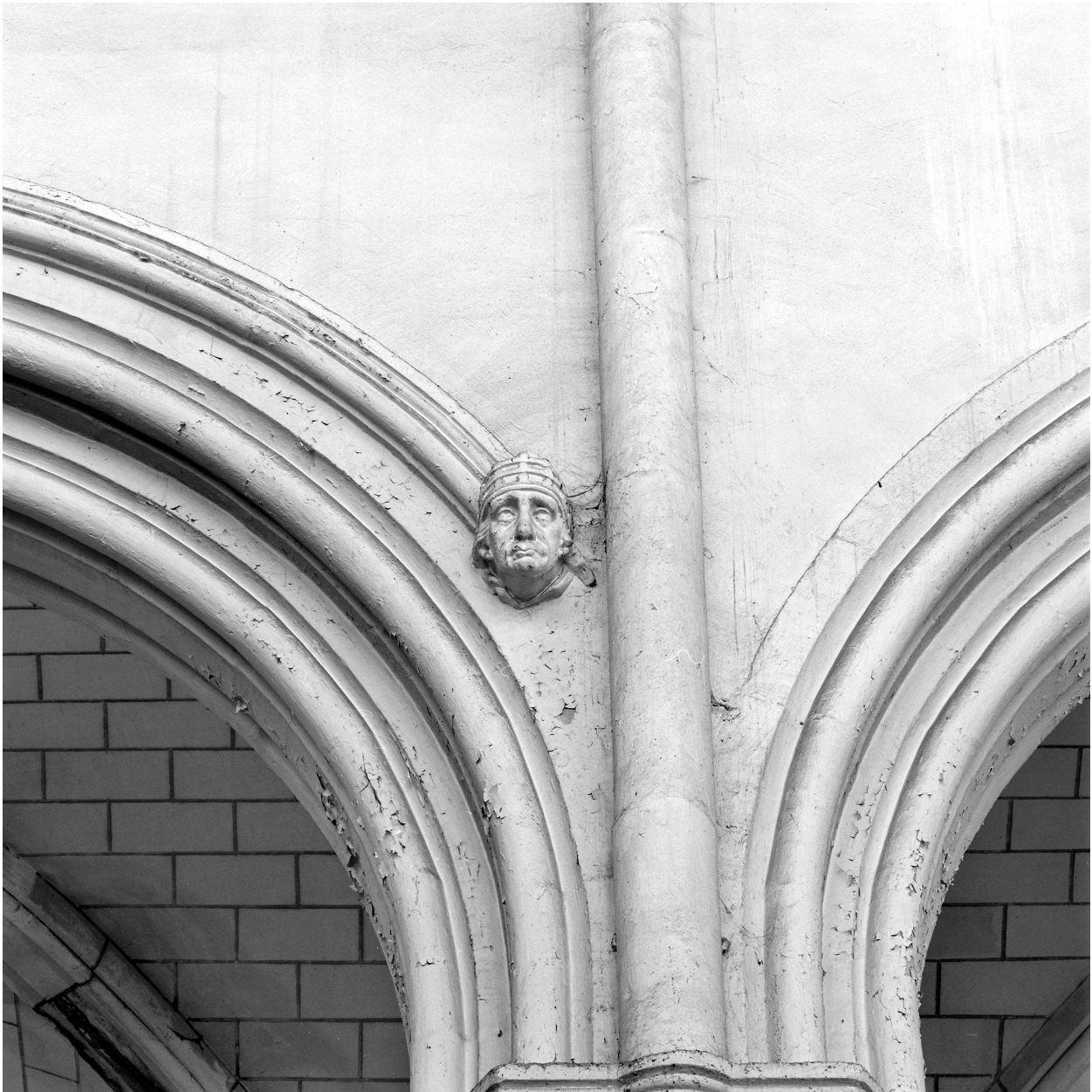
Choeur, côté sud, pilier n° 10, tête.
