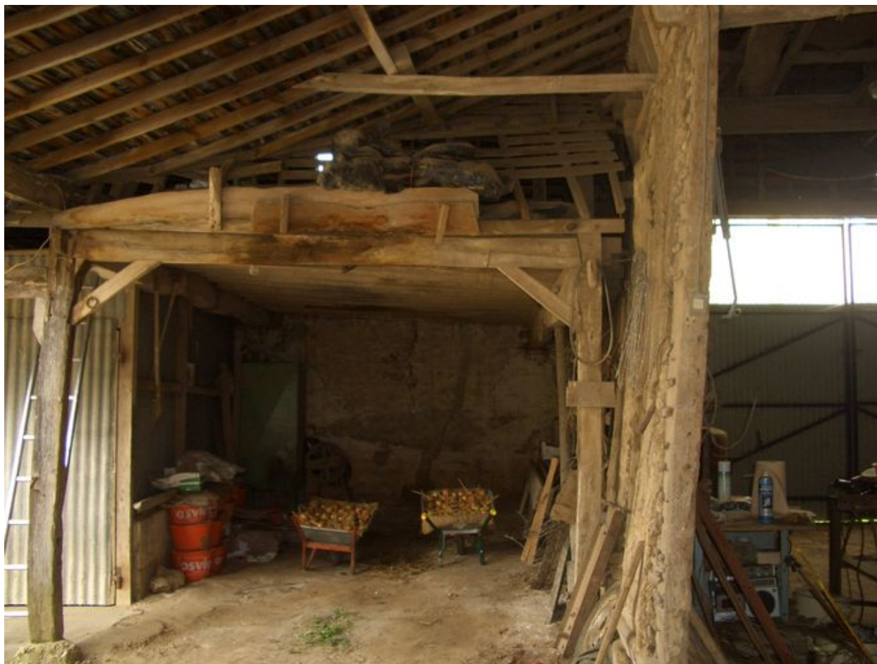
Compartiment séparé situe dans la grange.
