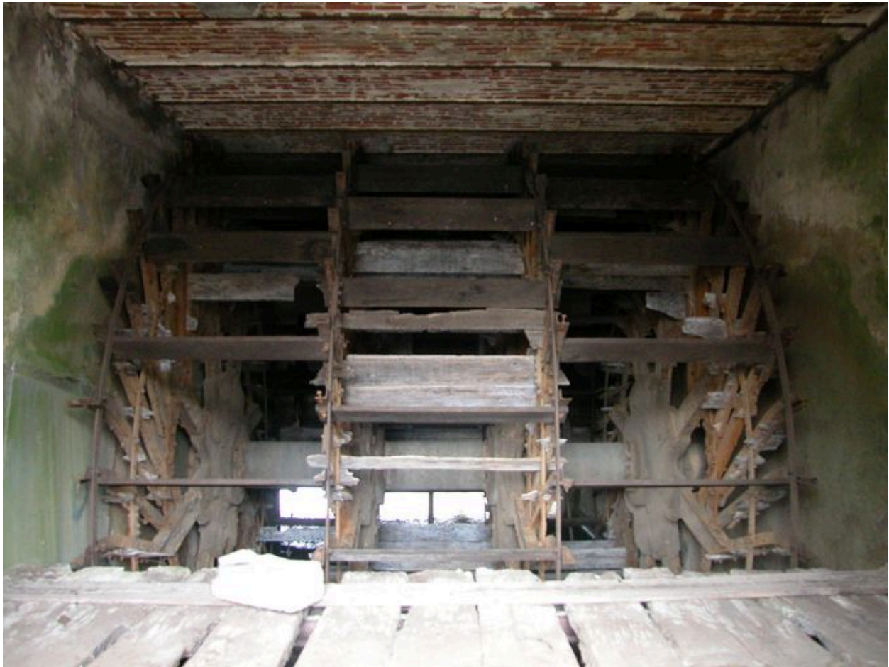
La roue hydraulique, vue de face.
