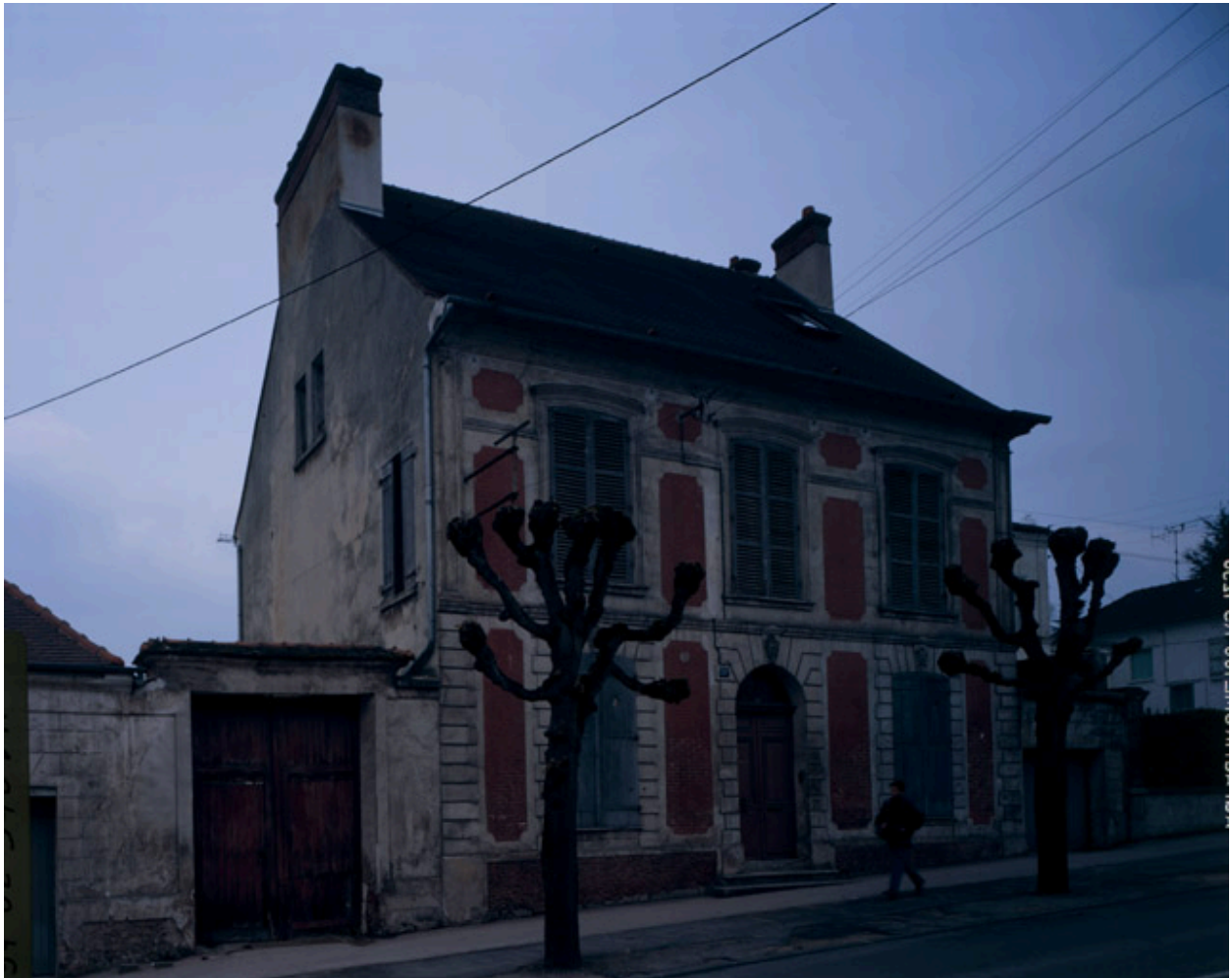
Vue d'ensemble depuis la rue.
