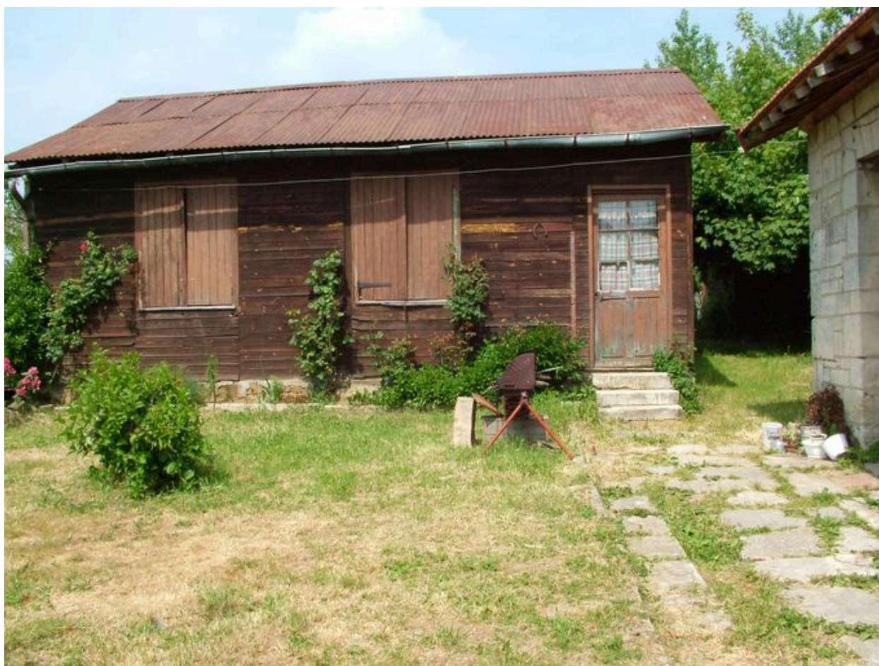
Vue d'une maison provisoire.
