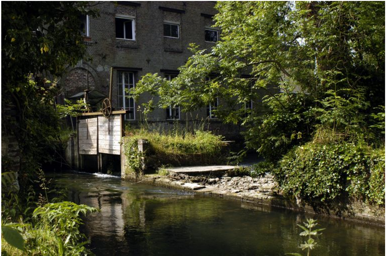
Le déversoir et le vannage de décharge.
