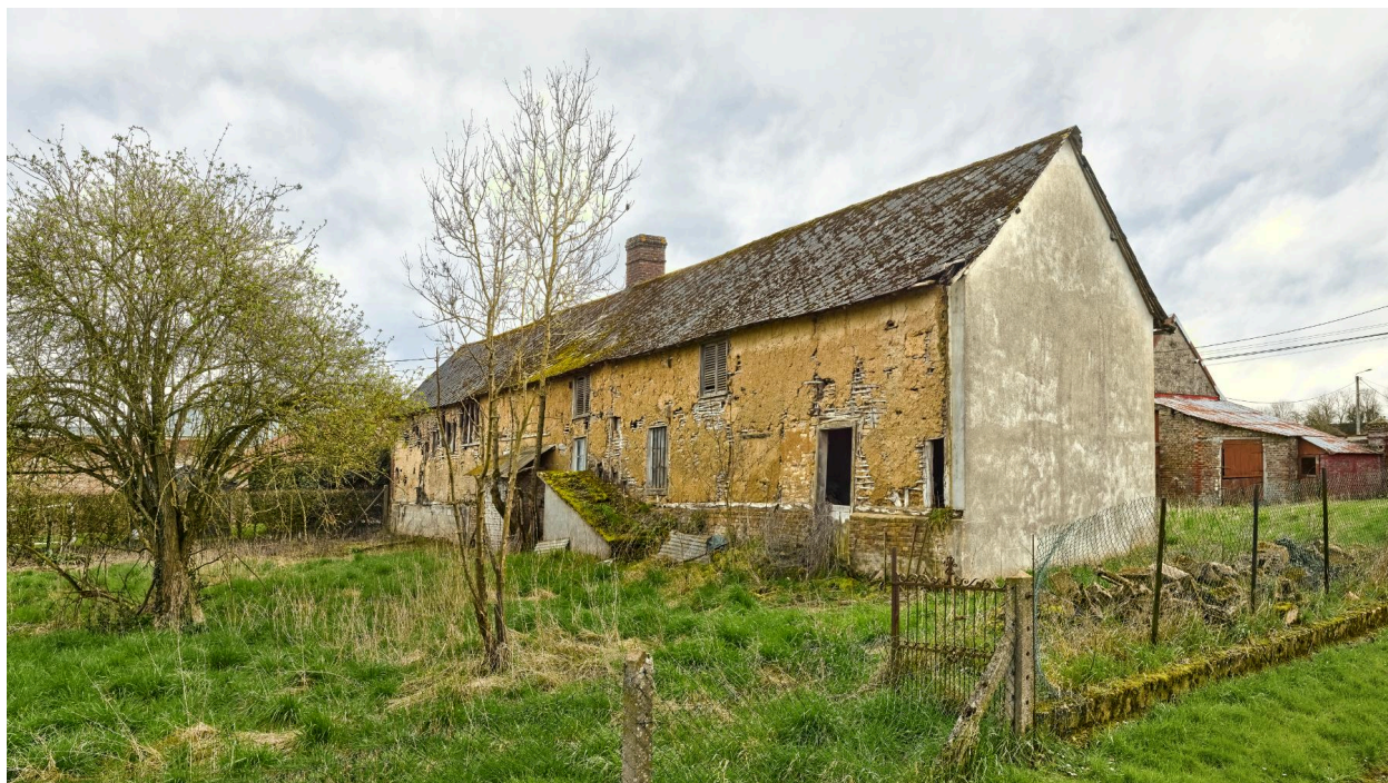
Habitation de la ferme, 132 rue des Allées, depuis le nord-ouest.
