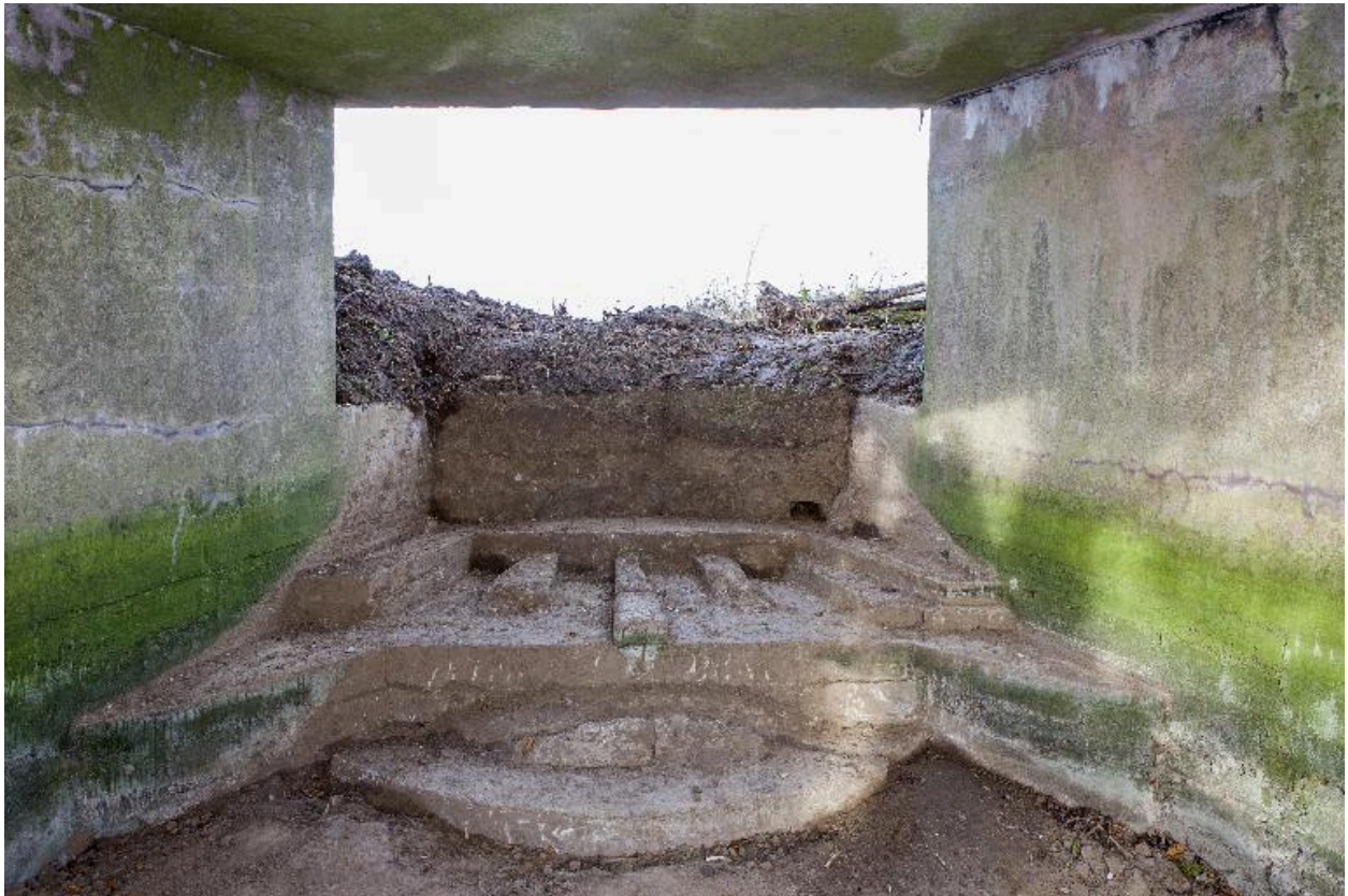
Vue intérieure de la chambre de tir, vers la sortie, avec au sol la plate-forme du canon
