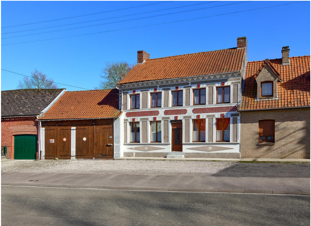
Maison, rue du Moulin.
