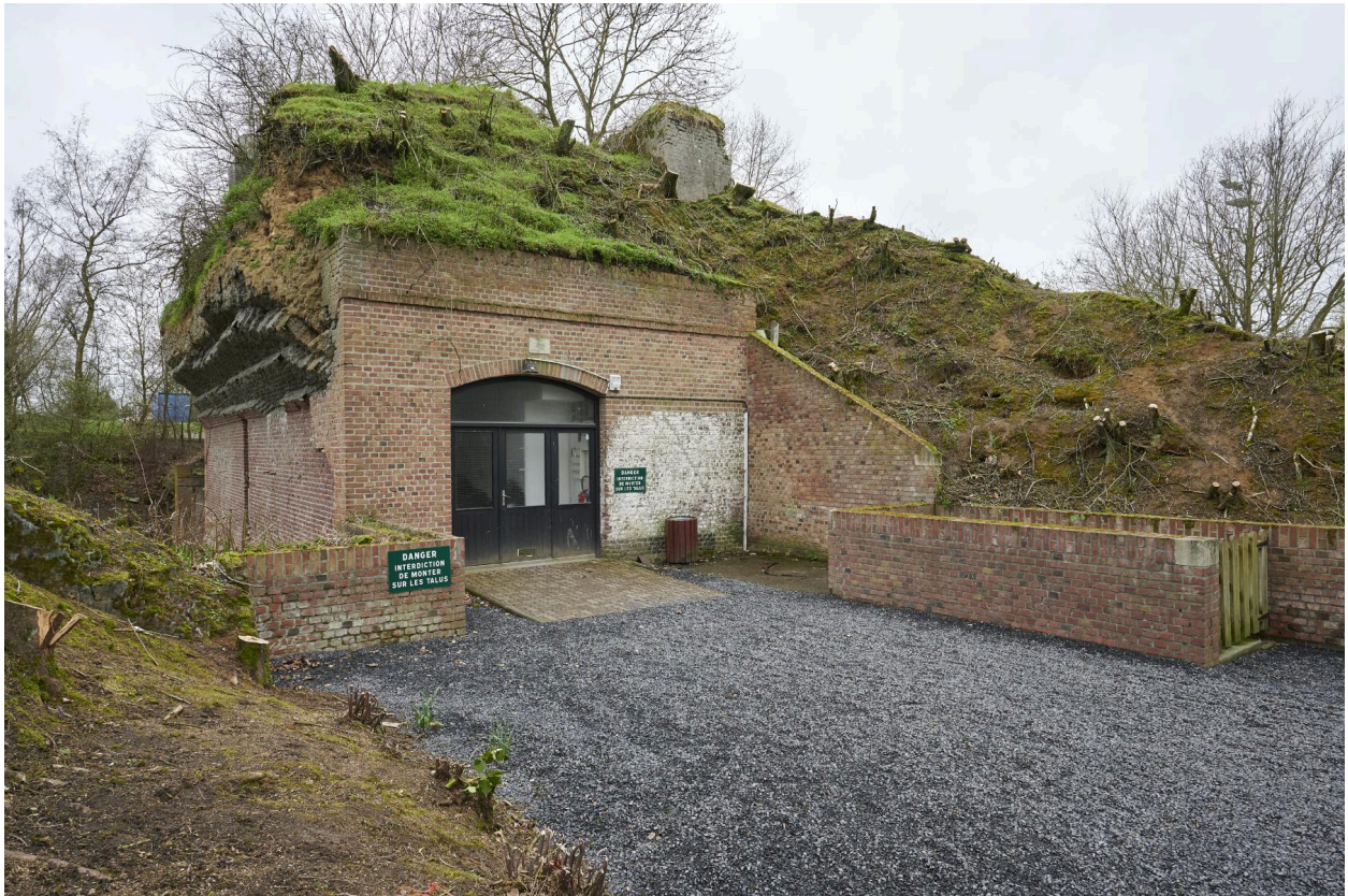
Atelier de chargement (artillerie) depuis la cour ouest.
