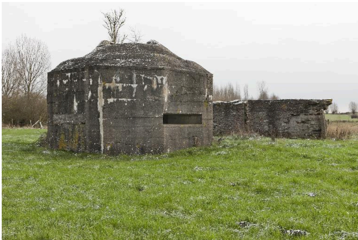
Casemate nord, vue vers le sud-sud-est
