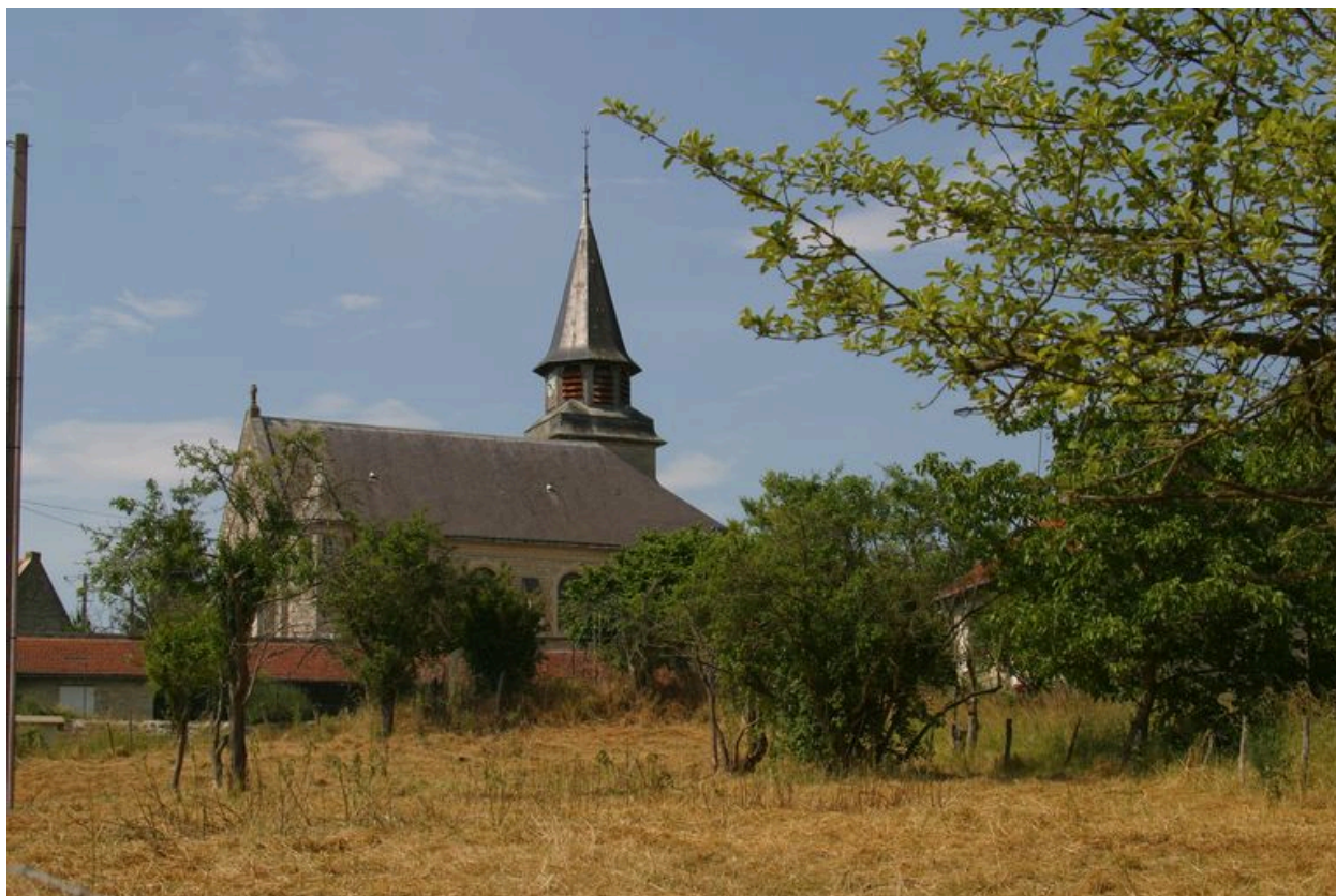
Vue latérale de l'église.
