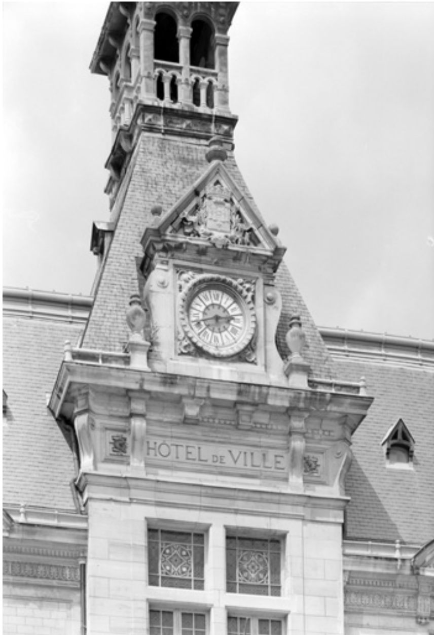
Détail de la façade, l'horloge.
