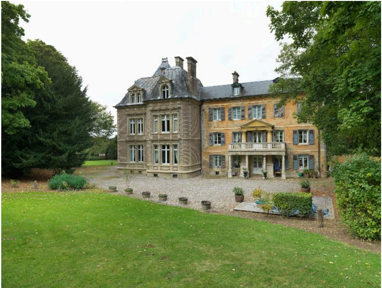
Vue d'ensemble de la façade sud du château, vue depuis le sud-est.
