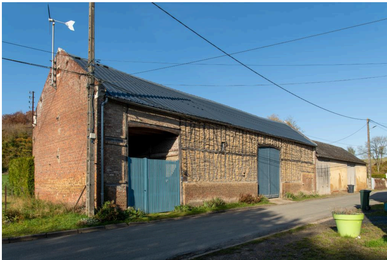
Grange sur rue avec entrée charretière, n°7 rue d'Empire, vue depuis le sud-est.
