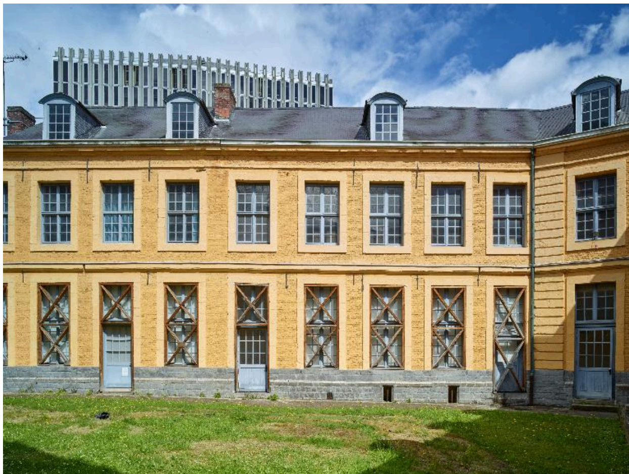
Cour secondaire, élévation du bâtiment situé au nord de la cour, qui abritait la salle de classe et le logement de l'économe, vue de face.
