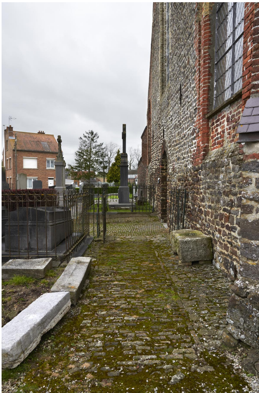
Allée pavée le long de la façade occidentale de l'église.
