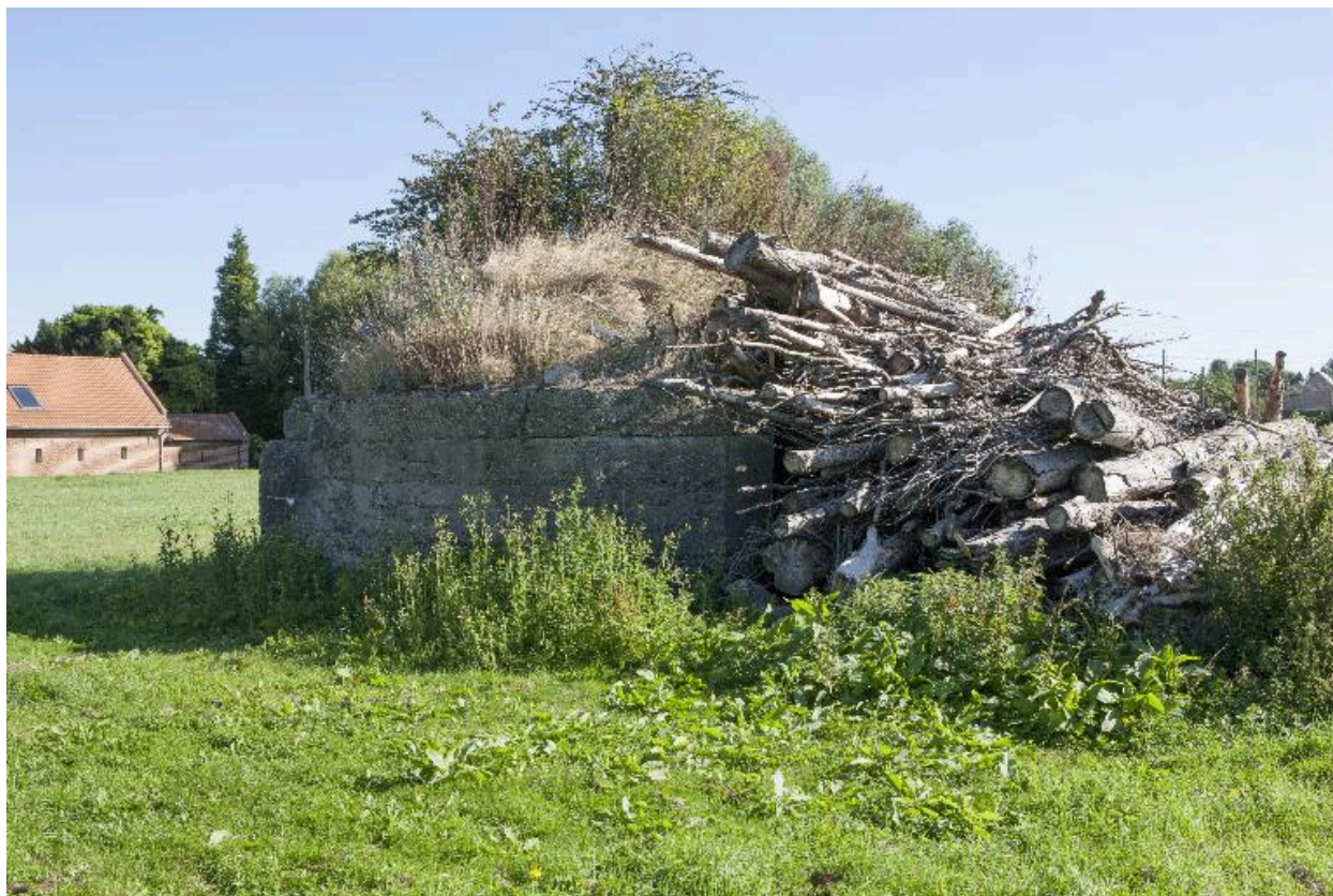
Vue vers le nord-est
