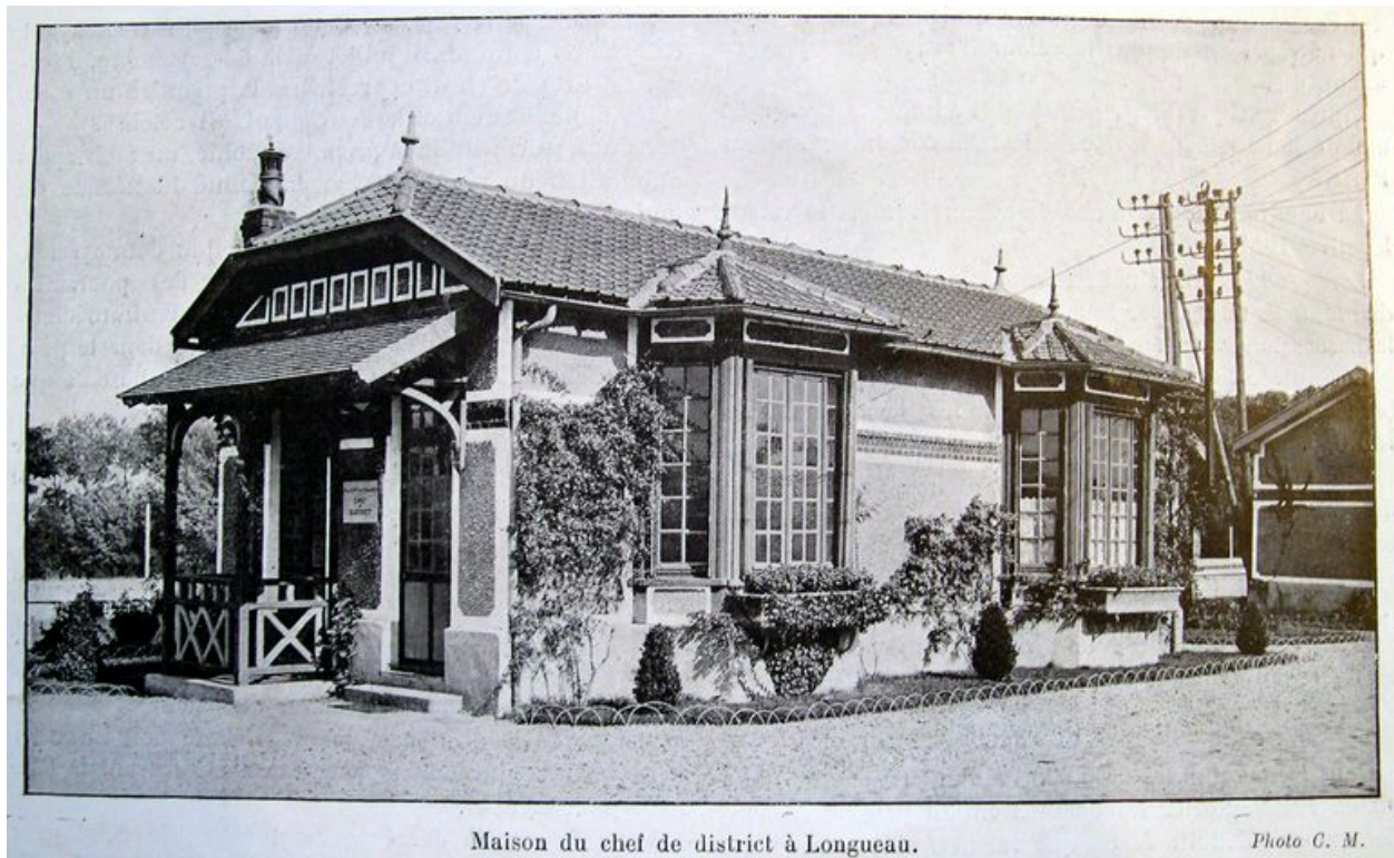
Maison du chef du district. La construction Moderne, n° 4, 24 octobre 1926.
