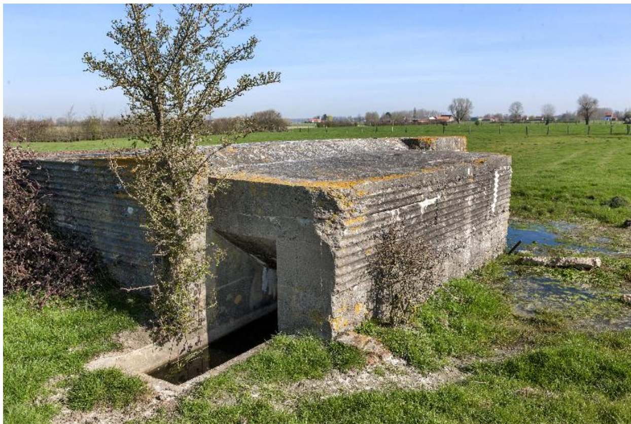
vue de trois-quarts vers le nord
