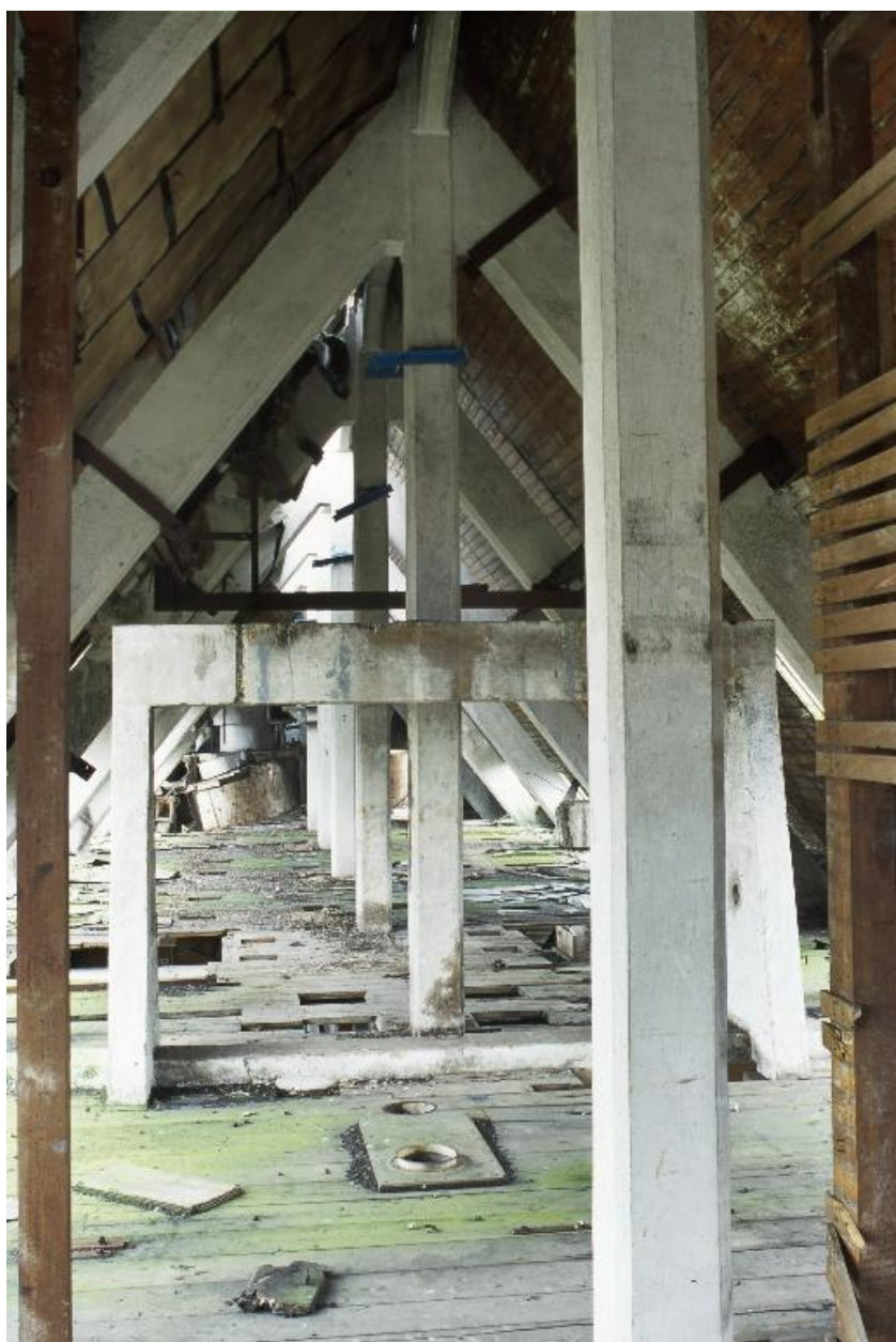
Bâtiment des moulins. Troisième niveau de comble.
