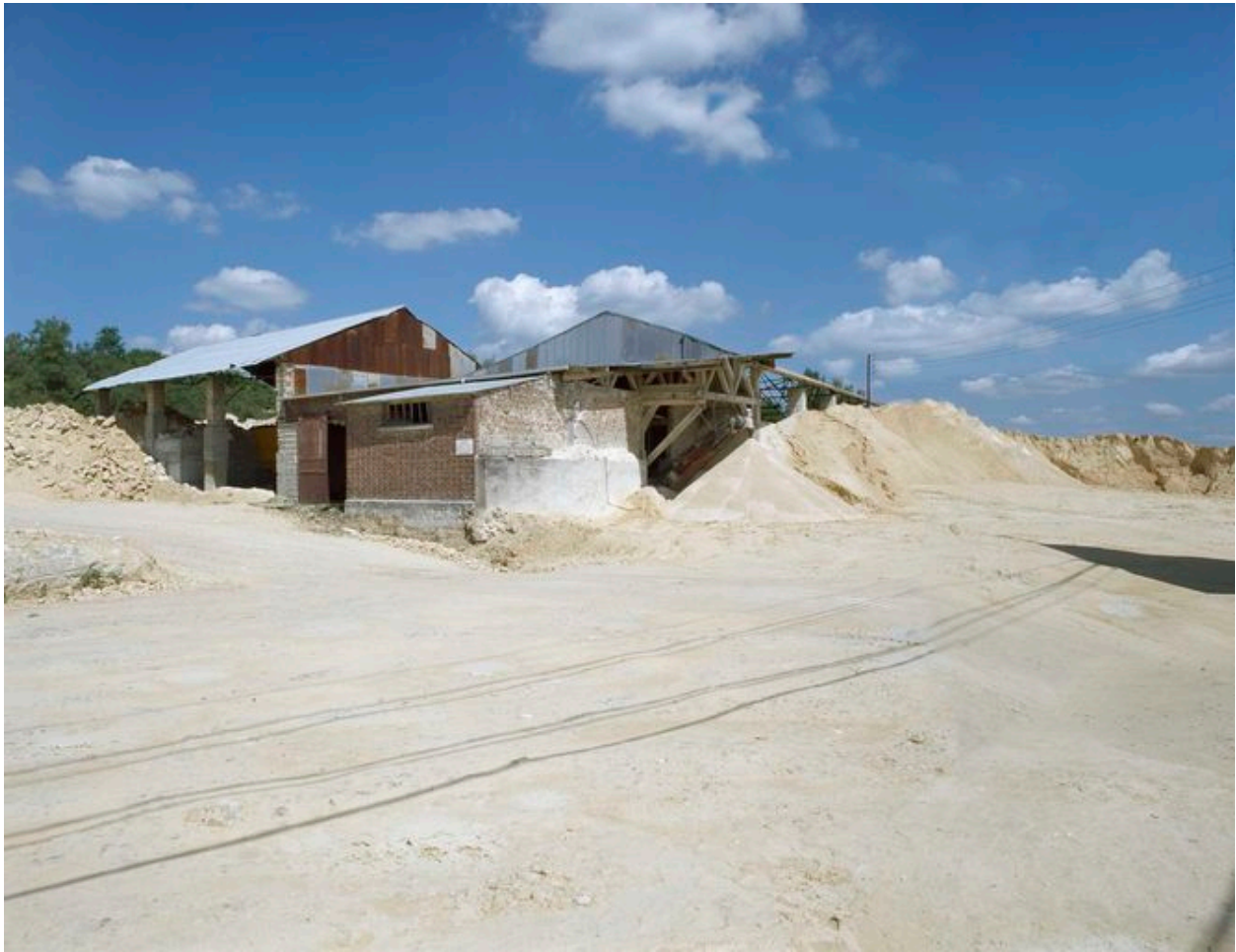
Atelier de concassage (carrière Ouachée-Corpechot, Saint-Maximin).
