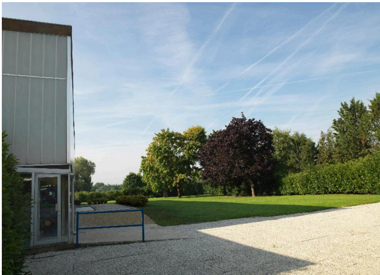
Entrée secondaire (aménagée à l'extrémité du "foyer") et jardin de la piscine.
