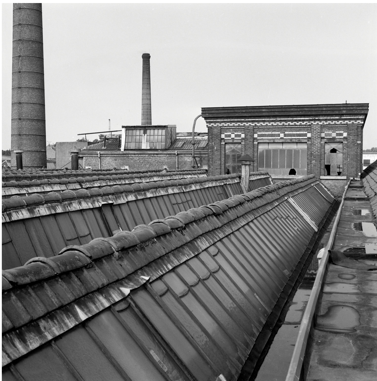
Ancienne salle des machines vue des toits.
