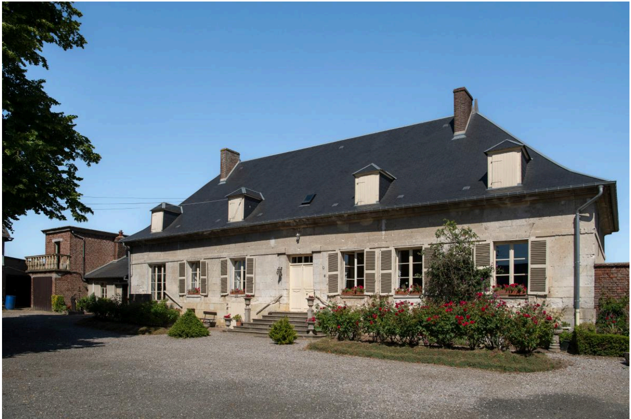
Logis de ferme construit en 1832, n°27 Neuve Rue, vue depuis l'est.
