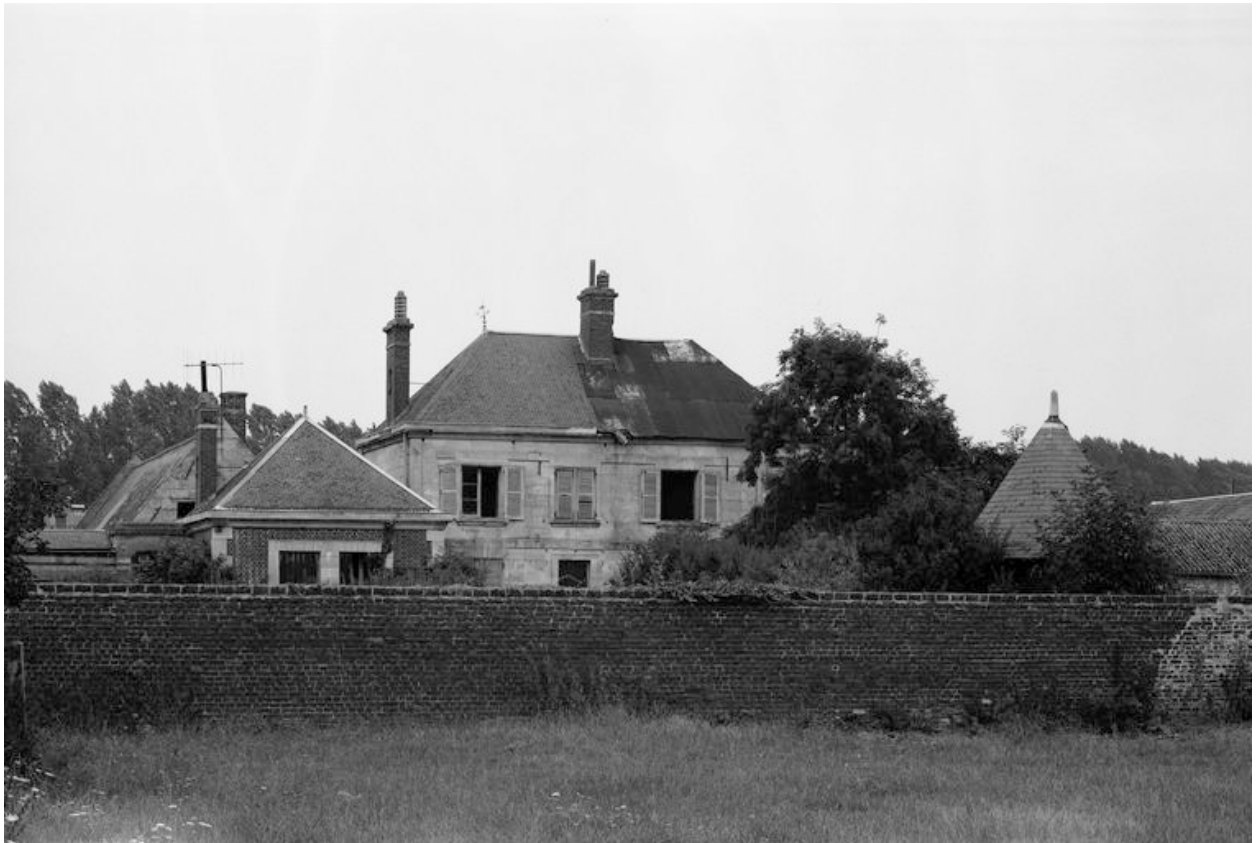
Vue générale postérieure.
