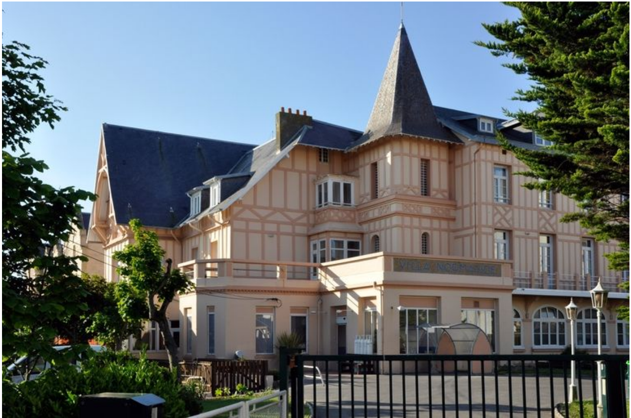
Vue générale, élévation rue Eugène-Trigoulet, en 2010.
