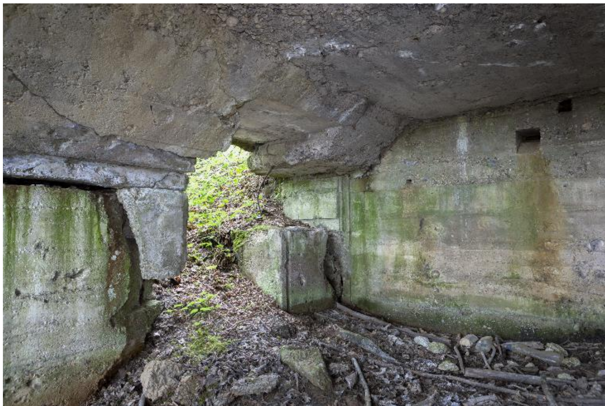
Casemate n°2, Vue intérieure
