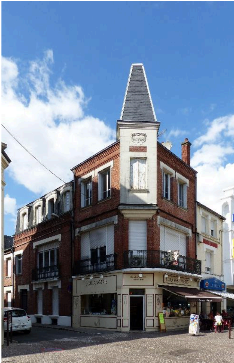
Maison à boutique, à l'angle de la rue des Juifs, reconstruit vers 1927.
