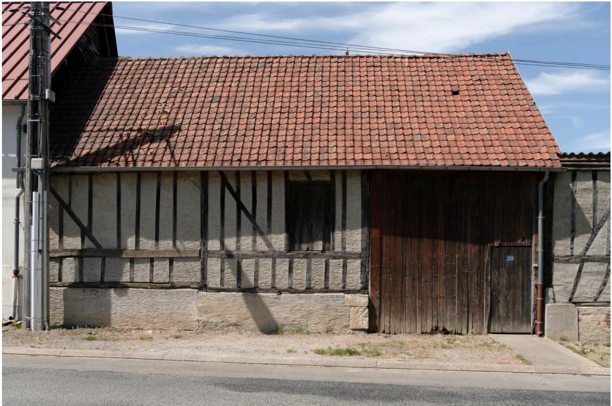
Ancienne grange sur rue avec porte à engranger, n°29 rue des Hayes, vue depuis le sud-est.
