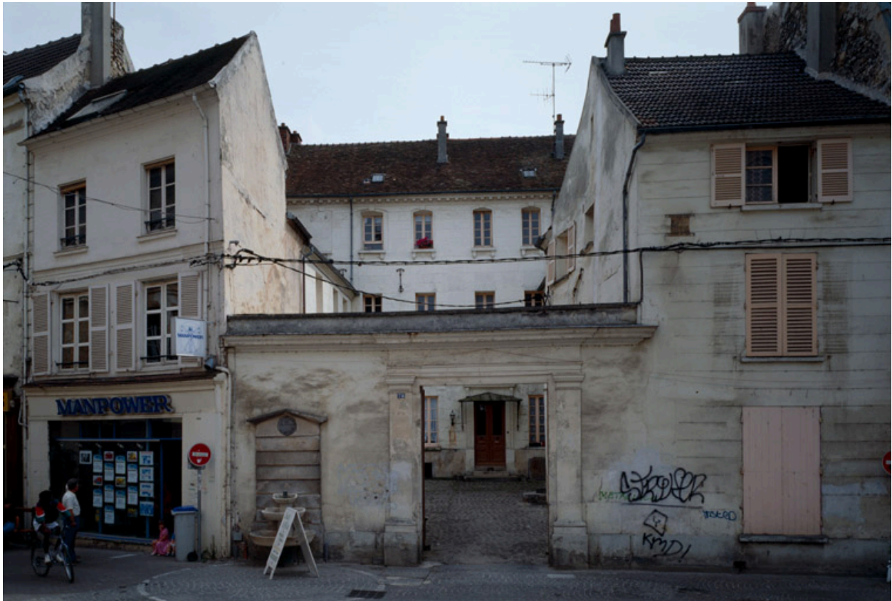
Vue d'ensemble depuis la rue.
