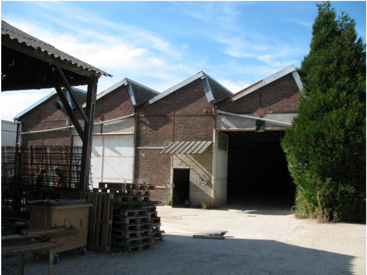
Anciens ateliers de vernissage et de vérification des fûts étanches.
